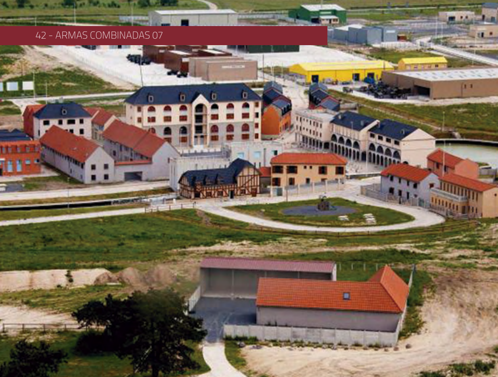
Vila de Jeoffrecourt - vista parcial das infraestruturas do Centre d'Entraînement aux Actions en Zones Urbaines
