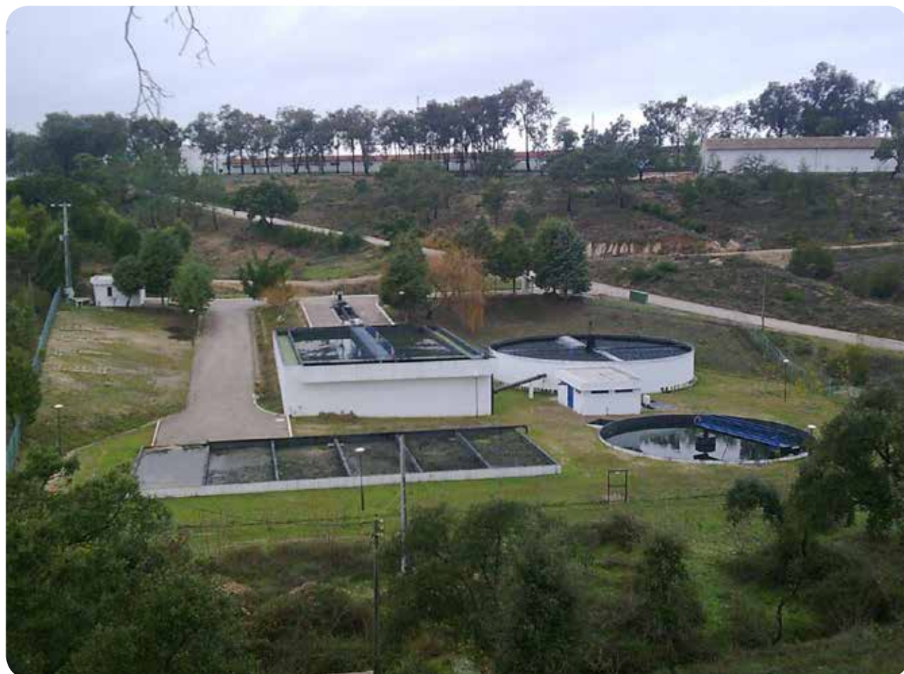
Fig.10 - Estação de Tratamento de Águas Residuais do Campo Militar de Santa Margarida.
