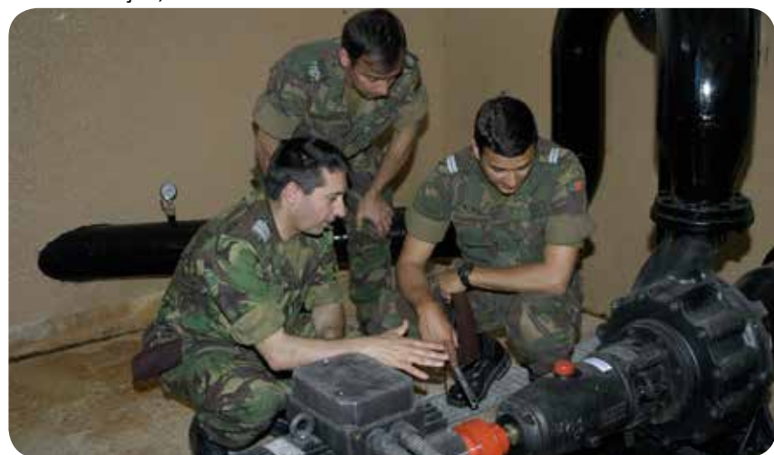
Fig.5 - Obras de arranque.
