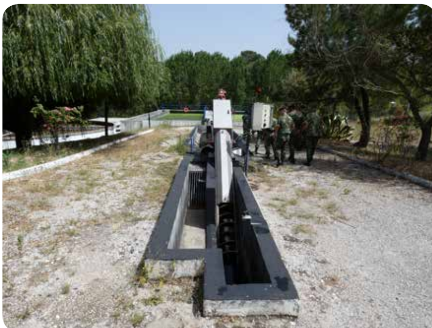
Fig.1 - Canal de entrada atual (Tamisador e Canal Parshall).
