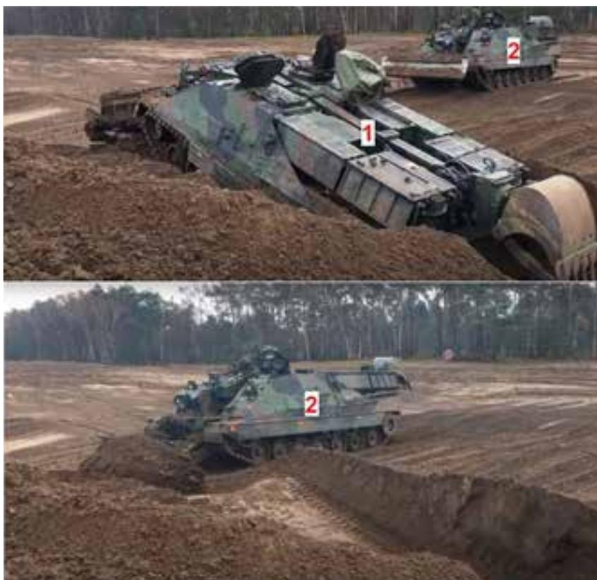
Fig. 6 – Metodologia de construção de um FACar retangular através de um PL materializado por 2 Kodiak do exército holandês; a viatura 1 é responsável pela escavação e a viatura 2 pela execução da barreira com o solo resultante dessa escavação
