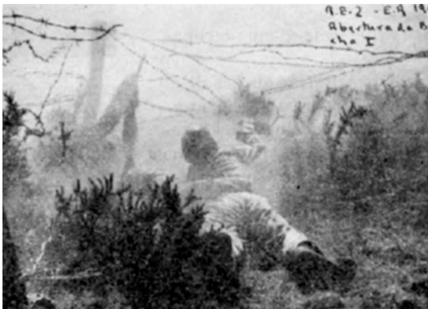
Figura 5 – Corte manual de redes para abertura de brechas
