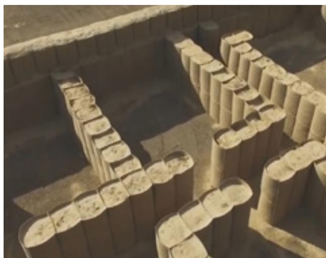
Figura 01: IT construída com bastiões HESCO.
