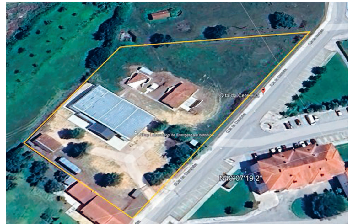
Fig. 1 - Vista satélite do terreno de implantação do LEDap e dos espaços cobertos
