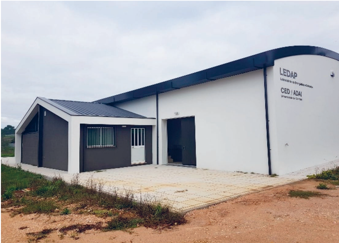
Fig. 2 - Vista da fachada principal do edifício central do LEDap
