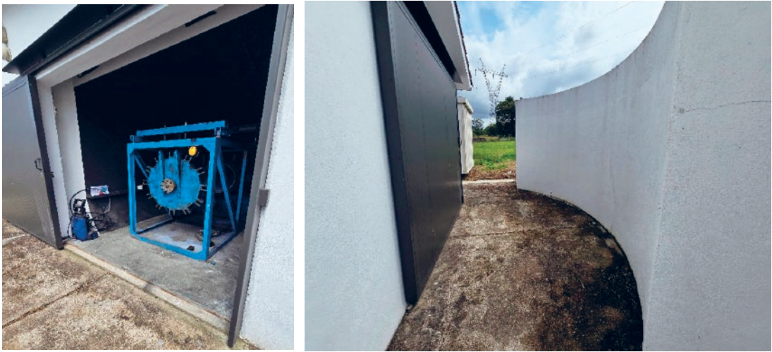
Fig. 8 - Túnel de ensaios de proergóis protegido por traveses junto das portas, no interior do qual se encontra uma câmara de 1 m3 para ensaios de detonação, sob efeito de vácuo
