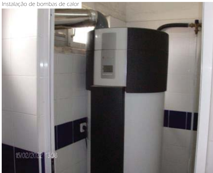
Instalação de bombas de calor
