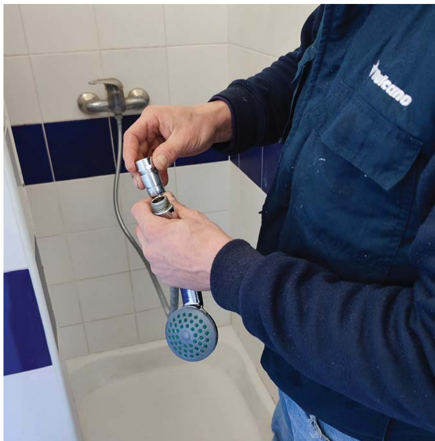
Instalação de redutores de caudal
